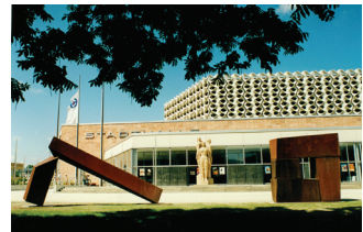
■ Arbeiten im öffentlichen Raum Stadthalle Chemnitz (2013)
